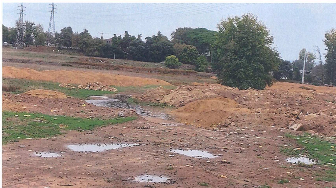
Foto 2 - Depósitos de terras, no centro do terreno, abaixo dos muros de pedra existentes.
