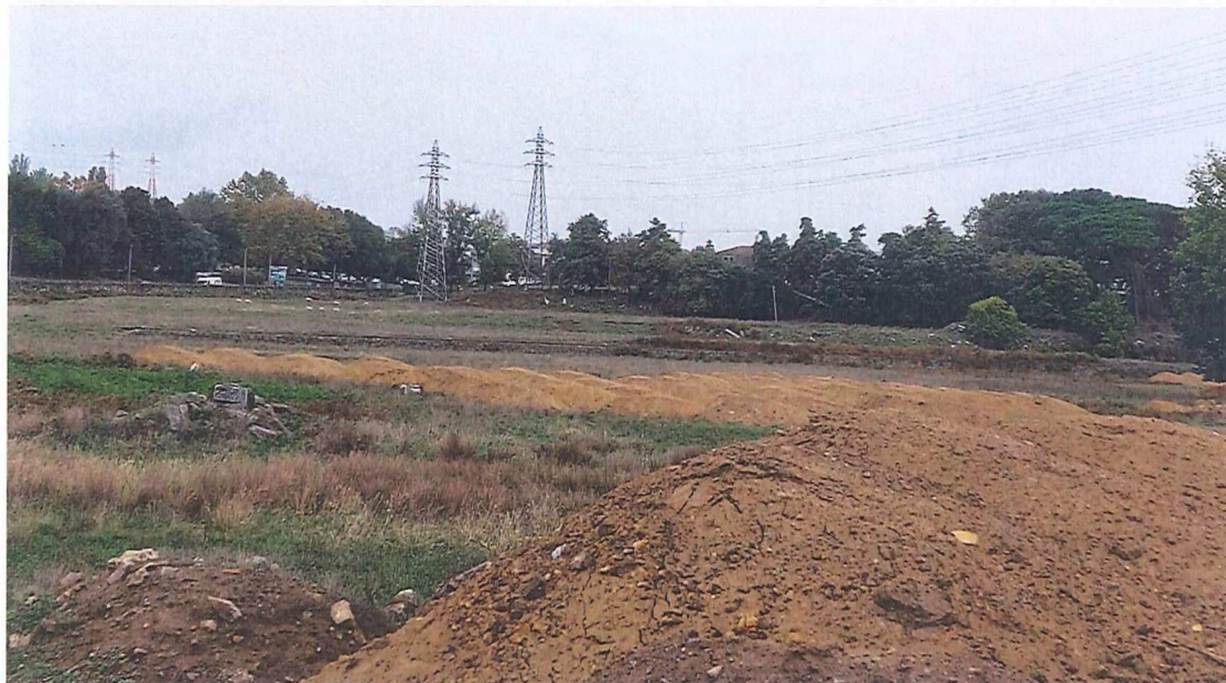
Foto 1 - Depósitos de terras, no centro do terreno, abaixo dos muros de pedra existentes.
