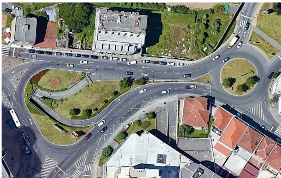
Figura 37 – Rotundas da Estação I, Braga 8
