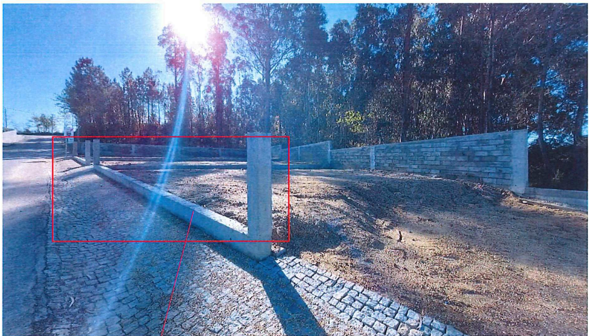
Lintéis de fundação e pilaretes do alçado principal
