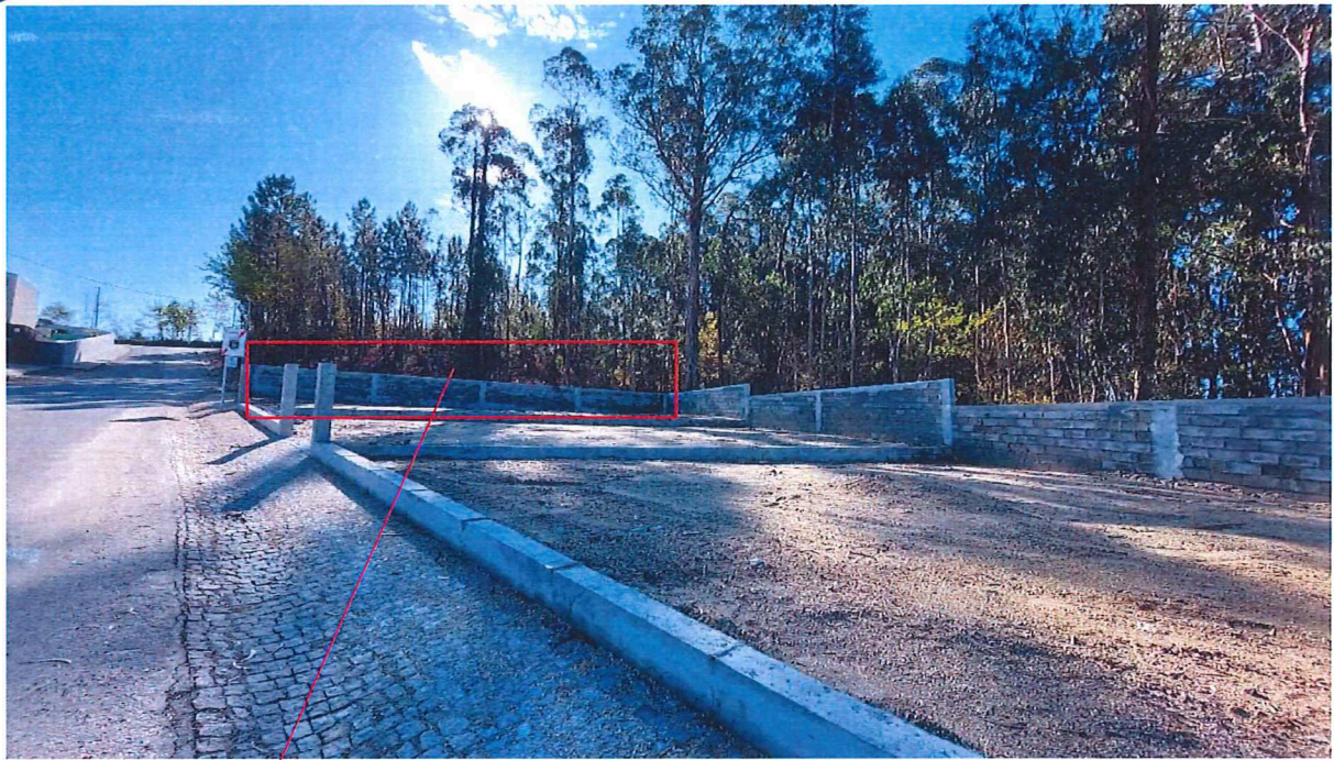
Muro lateral esquerdo
