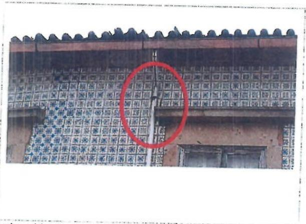
Obras de reparação: Retirada da caixilharia degradada, vidros e azulejos em risco de queda para a via pública, com posterior proteção da zona dos elementos retirados.
