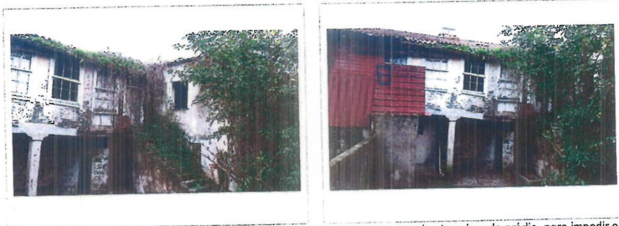
Obras de reparação: Proceder à vedação dos vãos abertos, na zona das traseiras do prédio, para impedir o acesso de intrusos ao seu interior, de forma a assegurar a sua segurança e evitar situações de insalubridade e/ou risco de incêndio.
