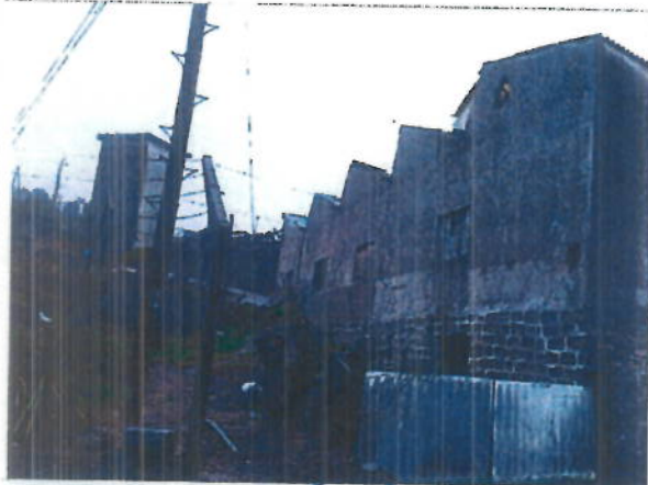
Cobertura em chapas de amianto em estado ruinoso ou inexistentes
