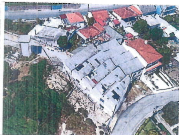
Cobertura em chapas de amianto em estado ruinoso ou inexistentes
