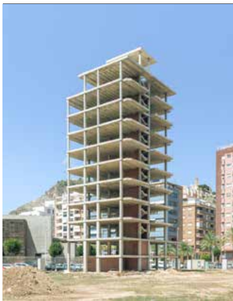
Edifício do Castelo
