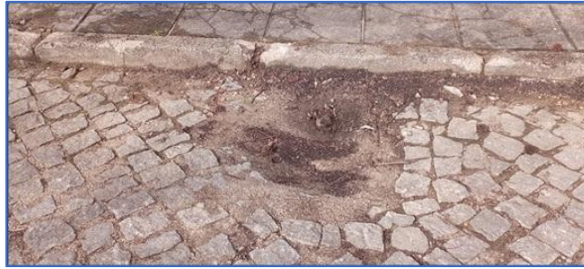
Figura 59 – Imagens do enquadramento da caldeira do ID30
