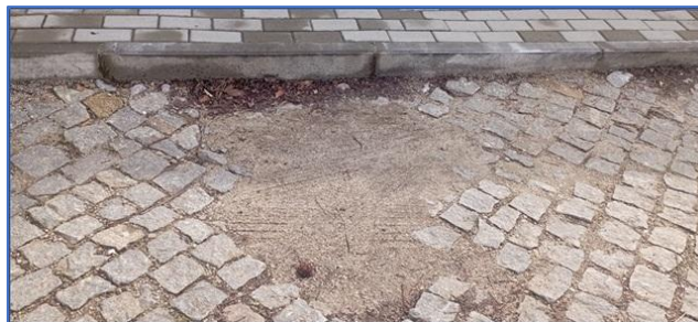
Figura 35 – Imagens do enquadramento da caldeira do ID17
