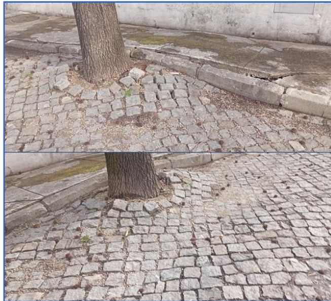
Figura 12 – Imagens de danos provocados pela árvore instalada no ID05
