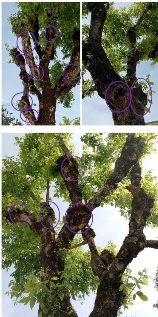
Figura 5 – Fotografias de lesões e cavidades na copa destas árvores, no troço da R. dos Bombeiros Voluntários, Braga.
