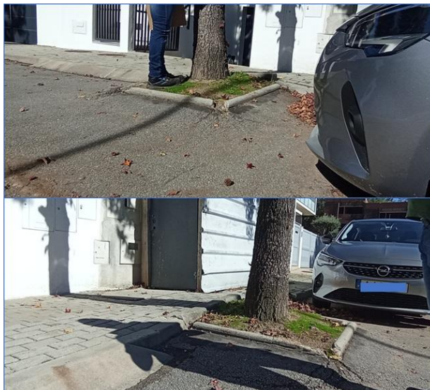
Figura 20 – Imagens de danos provocados pela árvore instalada no ID10
