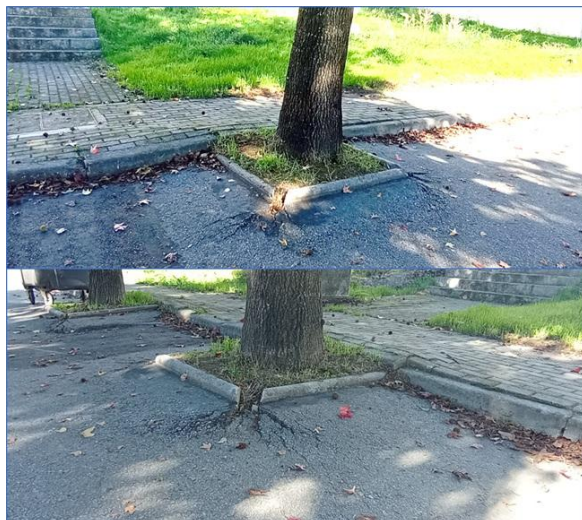
Figura 14 – Imagens de danos provocados pela árvore instalada no ID07
