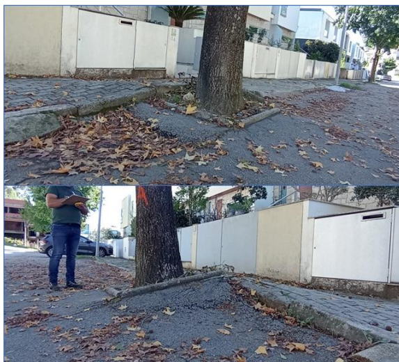
Figura 28 – Imagens de danos provocados pela árvore instalada no ID15
