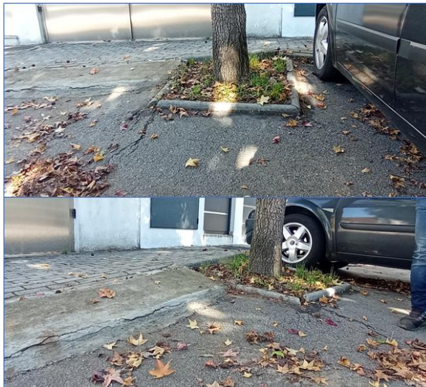
Figura 18 – Imagens de danos provocados pela árvore instalada no ID09
