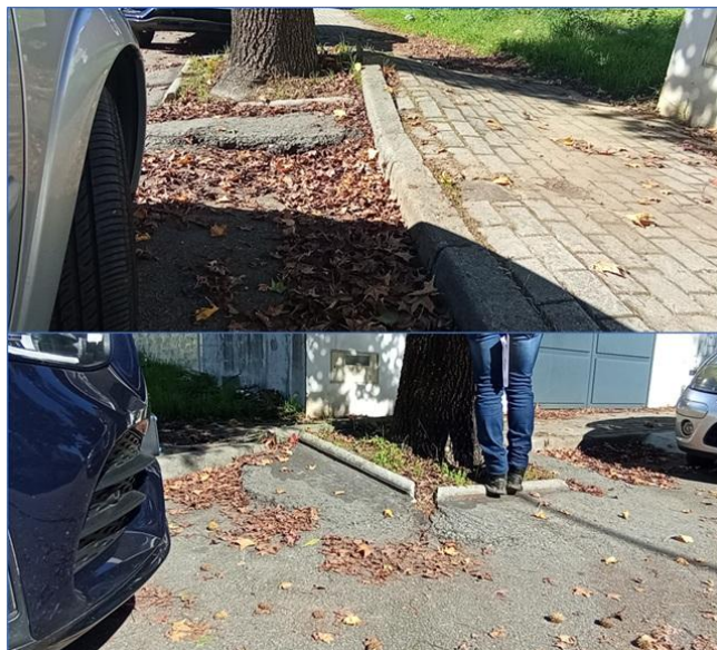
Figura 16 – Imagens de danos provocados pela árvore instalada no ID08
