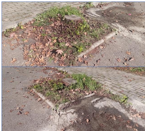
Figura 10 – Imagens do enquadramento da caldeira ID05
