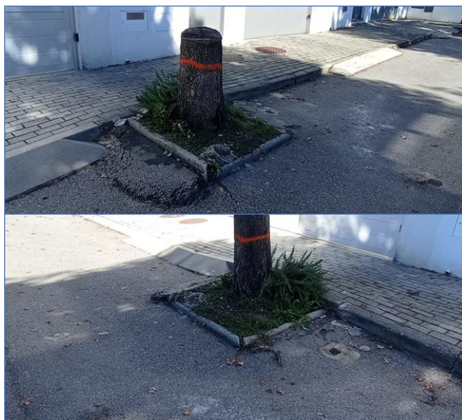
Figura 21 – Imagens do enquadramento da caldeira do ID11
