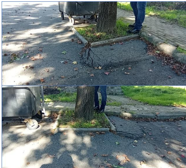
Figura 12 – Imagens de danos provocados pela árvore instalada no ID06
