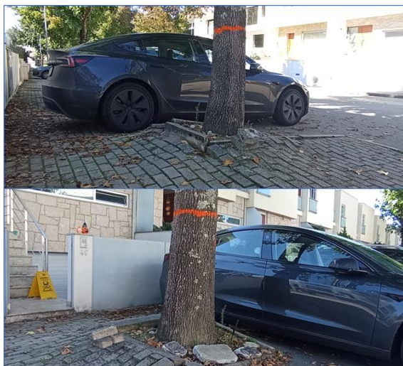
Figura 23 – Imagens de danos provocados pela árvore instalada no ID12
