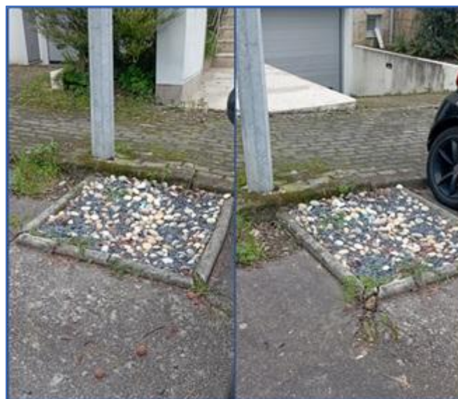
Figura 24 – Imagens de danos provocados junto à caldeira do ID15
