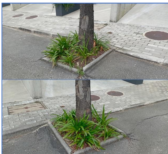
Figura 34 – Imagens de danos provocados junto à caldeira do ID21
