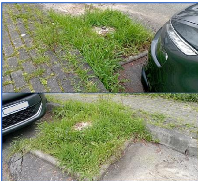
Figura 52 – Imagens do enquadramento da caldeira do ID31
