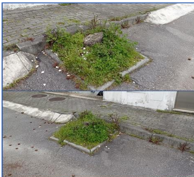
Figura 56 – Imagens do enquadramento da caldeira do ID34
