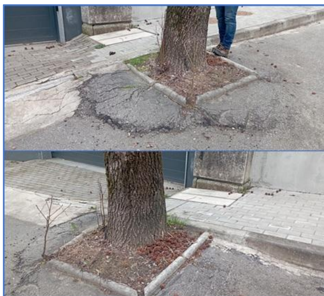
Figura 40 – Imagens de danos provocados junto à caldeira do ID24
