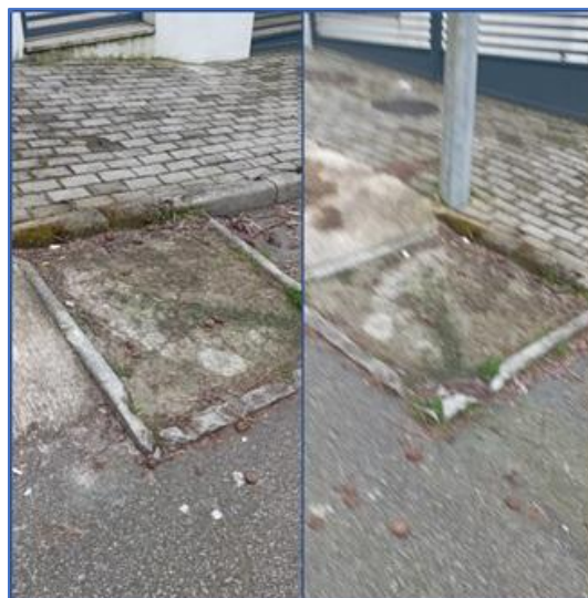
Figura 30 – Imagens do enquadramento da caldeira do ID19
