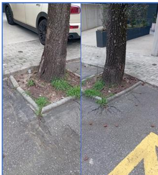
Figura 32 – Imagens de danos provocados junto à caldeira do ID20
