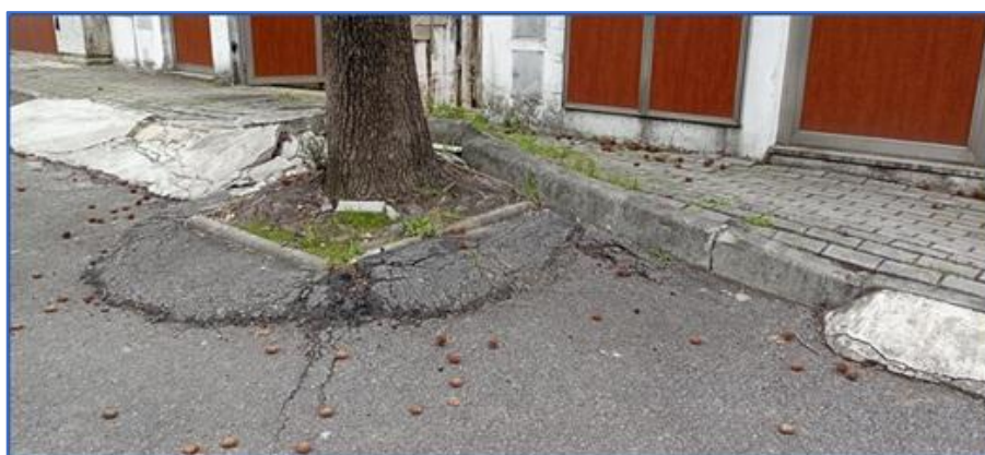
Figura 58 – Imagens de danos provocados junto à caldeira do ID35
