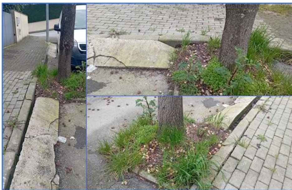
Figura 4 – Imagens de danos provocados pela árvore instalada no ID01
