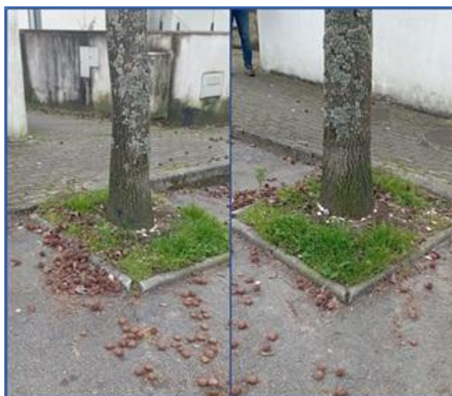
Figura 20 – Imagens de danos provocados pela árvore instalada no ID12
