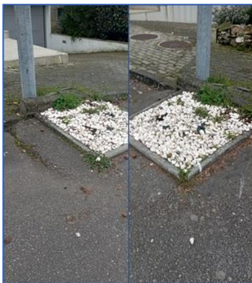
Figura 21 – Imagens do estado da caldeira do ID13
