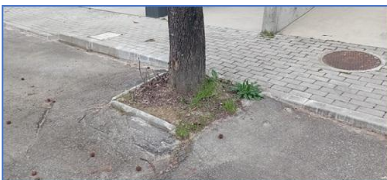
Figura 38 – Imagens de danos provocados junto à caldeira do ID23
