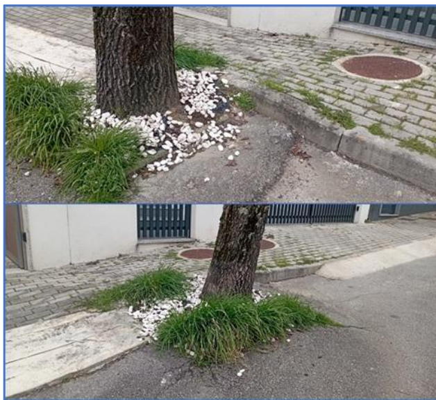
Figura 42 – Imagens de danos provocados junto à caldeira do ID25
