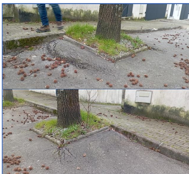
Figura 18 – Imagens de danos provocados pela árvore instalada no ID11
