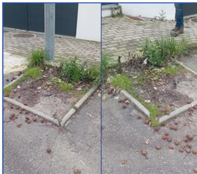
Figura 16 – Imagens do enquadramento da caldeira do ID10
