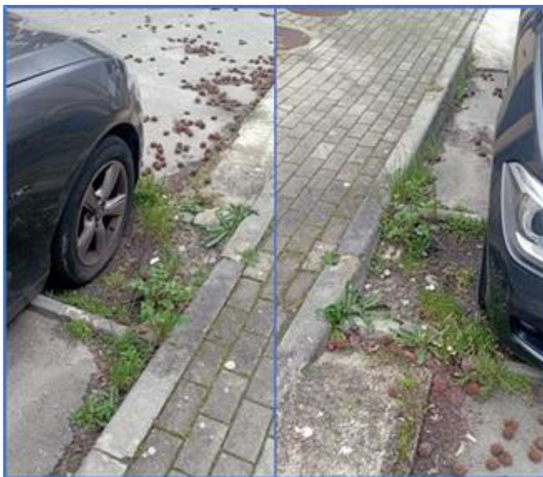
Figura 6 – Imagens do enquadramento da caldeira do ID03
