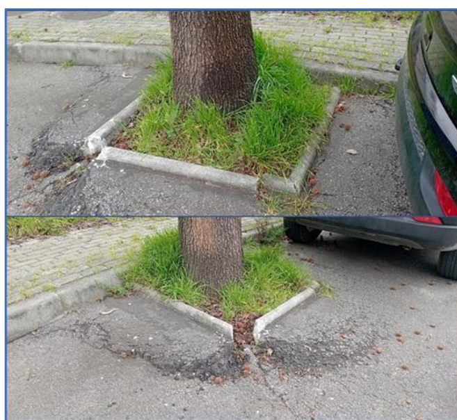
Figura 54 – Imagens de danos provocados junto à caldeira do ID32
