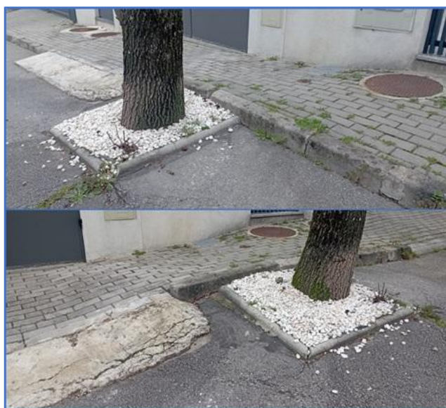
Figura 44 – Imagens de danos provocados junto à caldeira do ID26
