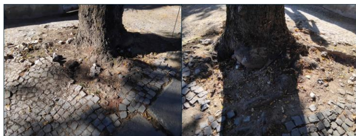
Figura 4 – Aspeto da caldeira
