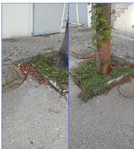
Figura 20 – Imagens de danos provocados pela árvore instalada no ID10
