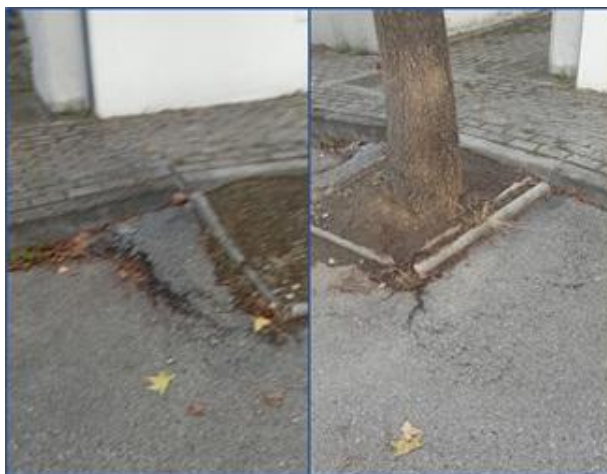
Figura 24 – Imagens de danos provocados pela árvore instalada no ID12
