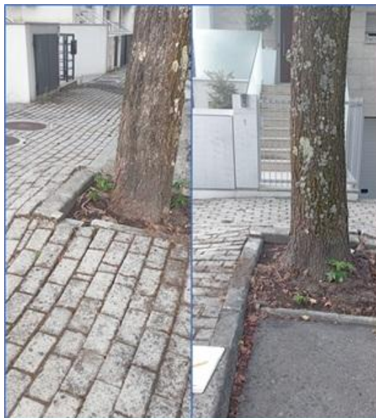
Figura 4 – Imagens de danos provocados pela árvore instalada no ID01
