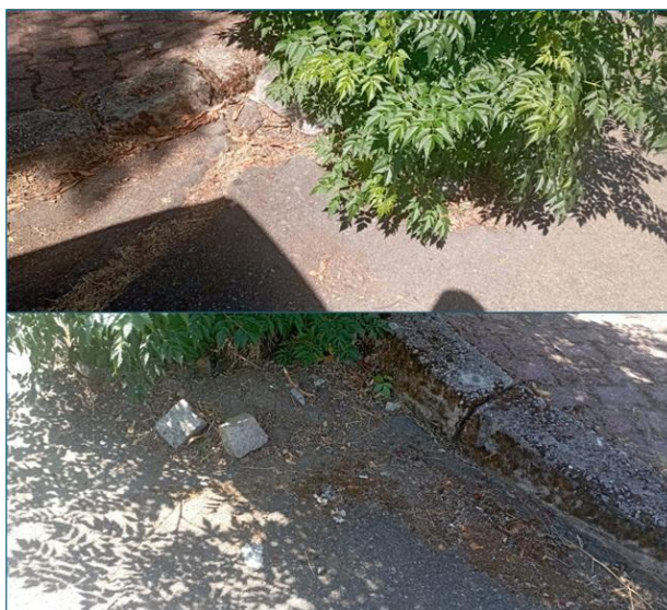
Figura 4 – Aspecto da caldeira
