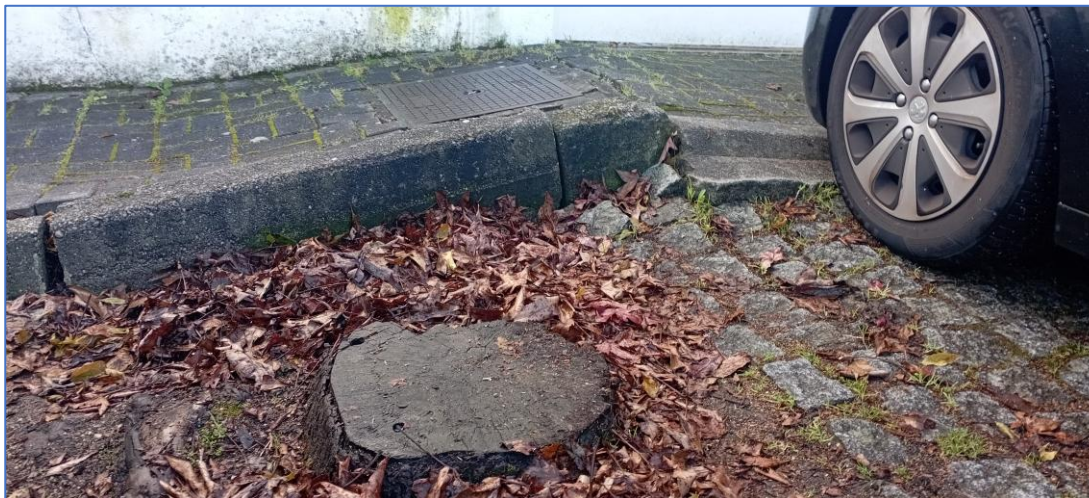
Figura 5 – Imagens do enquadramento da caldeira ID02
