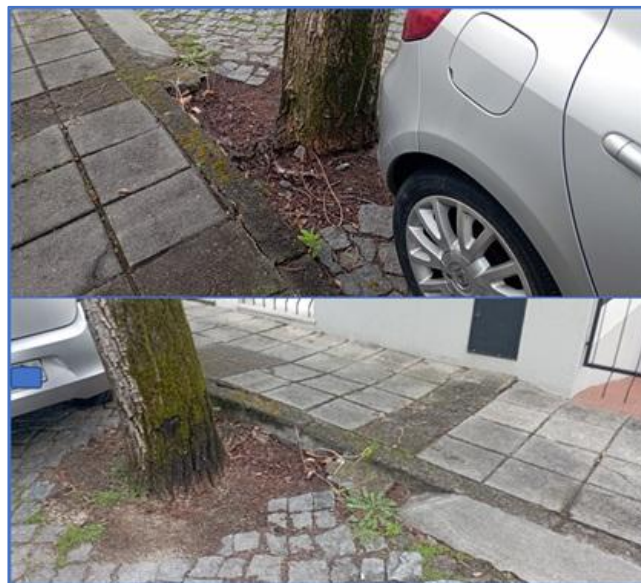
Figura 10 – Imagens da caldeira do ID03
