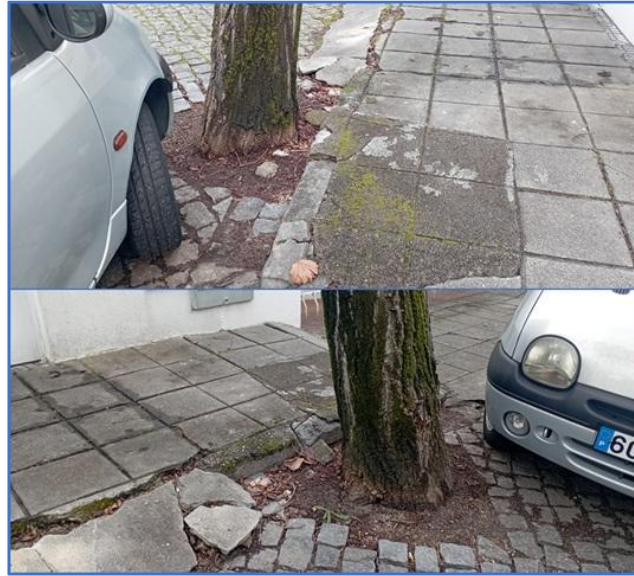
Figura 13 – Imagens da caldeira do ID04
