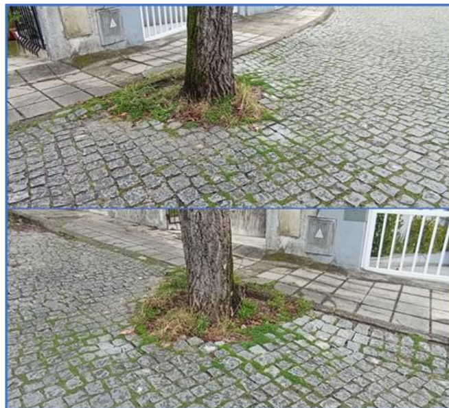
Figura 4 – Imagens da caldeira do ID01
