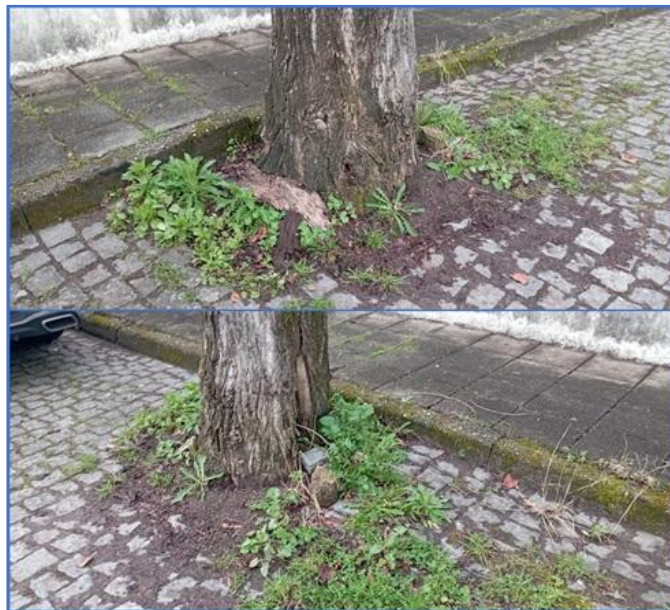
Figura 24 – Imagens da caldeira do ID10
