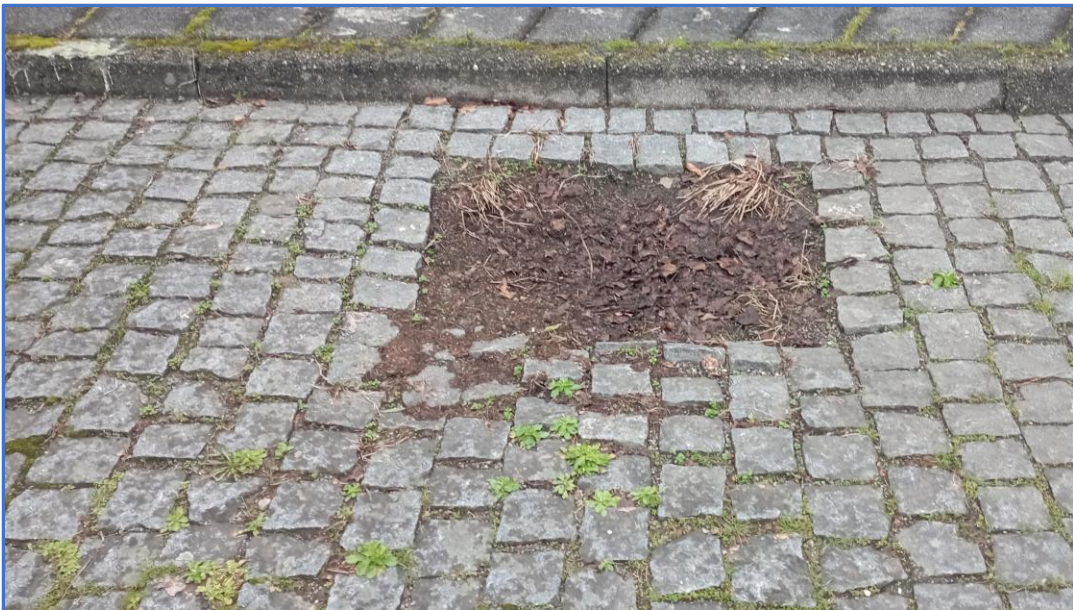
Figura 20 – Imagens do enquadramento da caldeira do ID08
