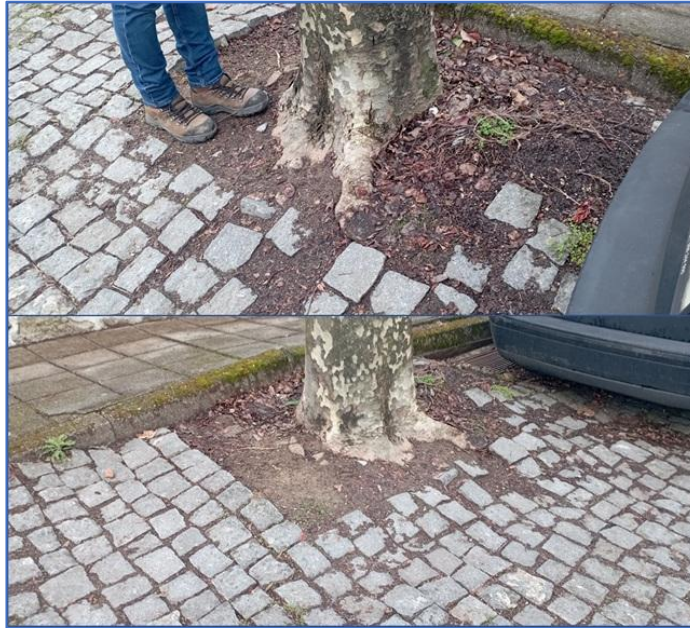
Figura 33 – Imagens da caldeira do ID13
