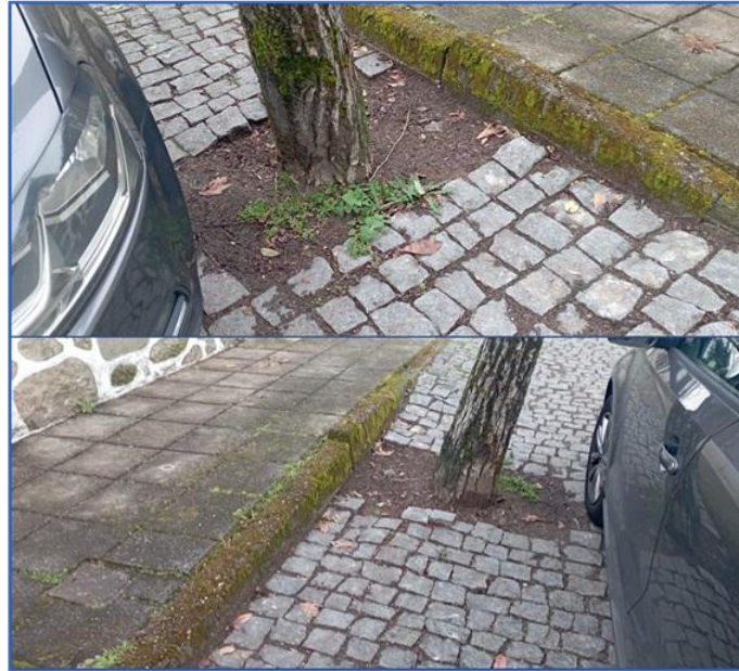
Figura 35 – Imagens da caldeira do ID14
