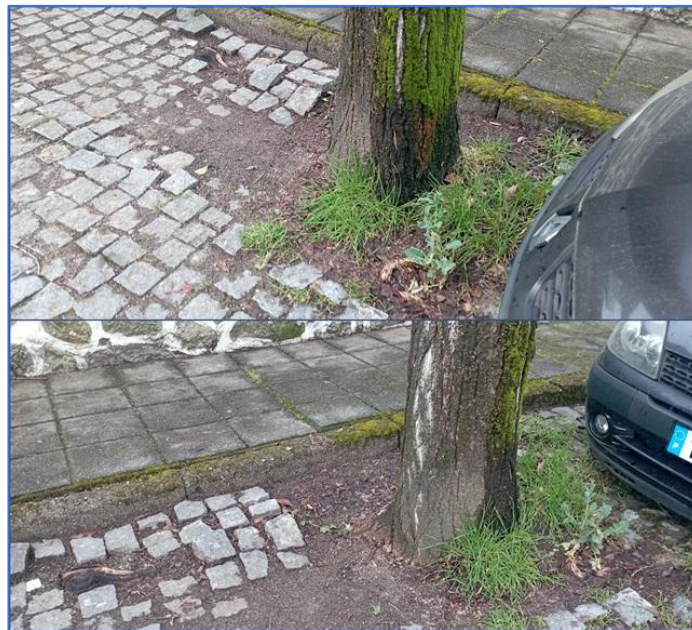
Figura 30 – Imagens da caldeira do ID12
