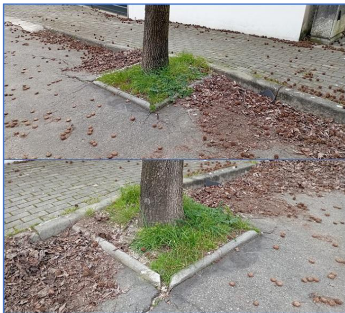
Figura 34 – Imagens de danos provocados junto à caldeira do ID20
