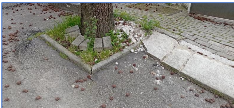
Figura 18 – Imagens de danos provocados junto à caldeira do ID10
