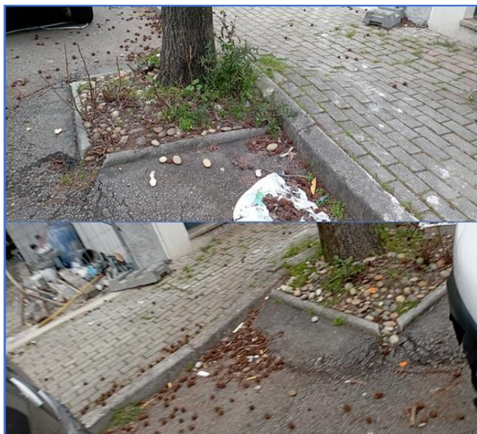
Figura 25 – Imagens de danos provocados junto à caldeira do ID15
