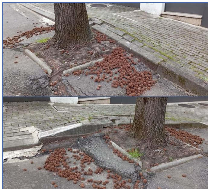
Figura 52 – Imagens de danos provocados junto à caldeira do ID29
