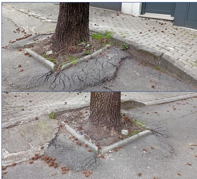
Figura 54 – Imagens de danos provocados junto à caldeira do ID30
