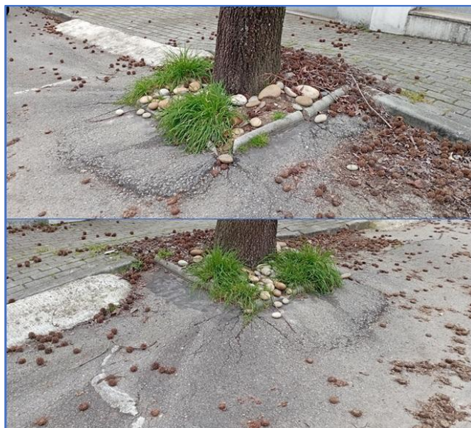
Figura 30 – Imagens de danos provocados junto à caldeira do ID18
