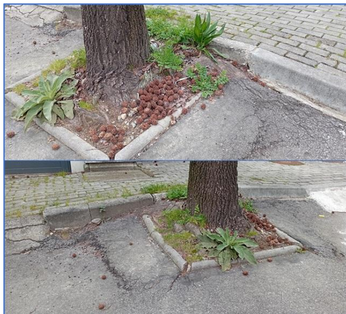
Figura 42 – Imagens de danos provocados junto à caldeira do ID24
