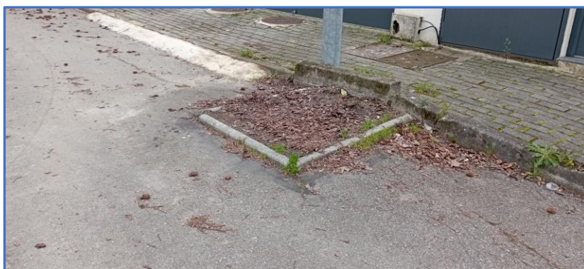
Figura 13 – Imagens de danos provocados junto à caldeira do ID07
