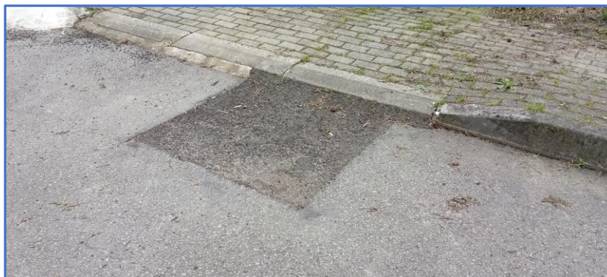
Figura 10 – Imagens do estado da caldeira do ID05
