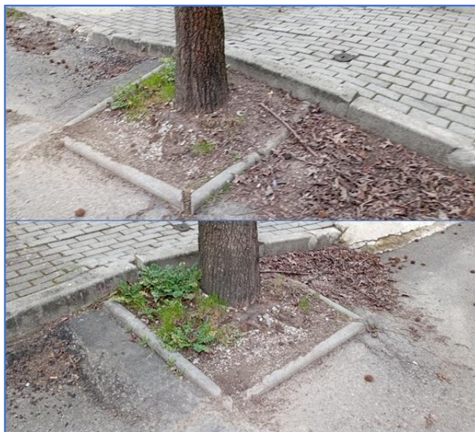
Figura 40 – Imagens de danos provocados junto à caldeira do ID23
