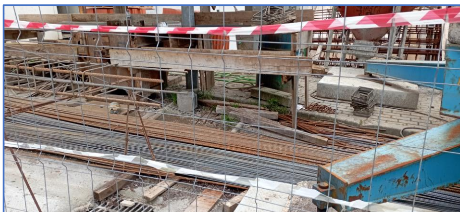
Figura 21 – Imagens do enquadramento da caldeira do ID12
