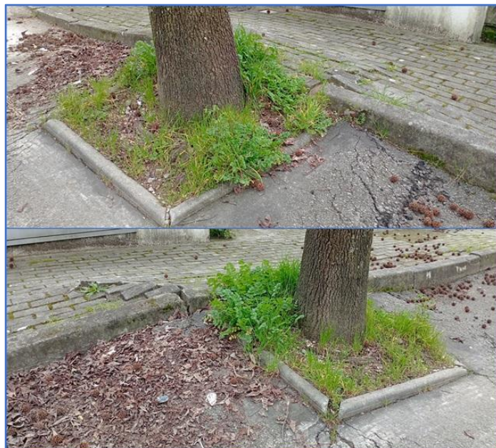
Figura 20 – Imagens de danos provocados junto à caldeira do ID11
