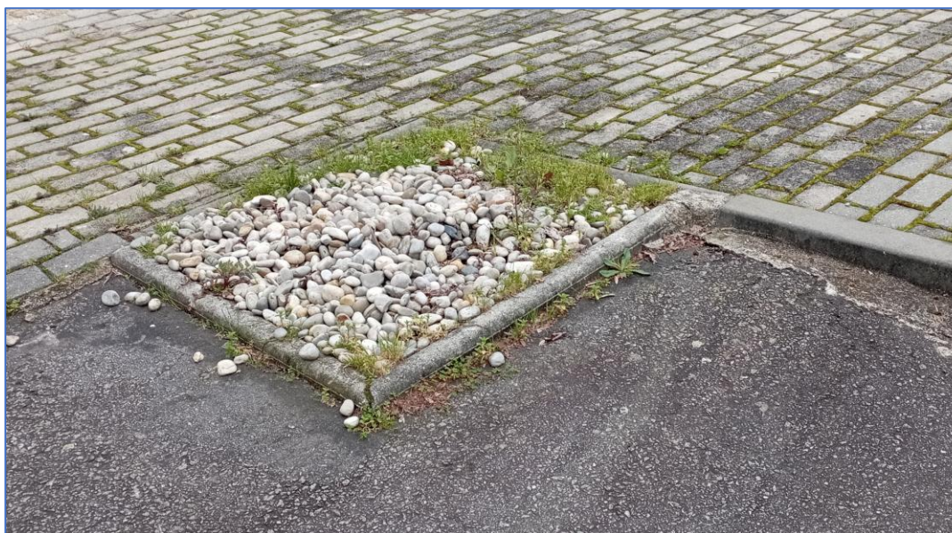
Figura 3 – Imagens do enquadramento da caldeira do ID01
