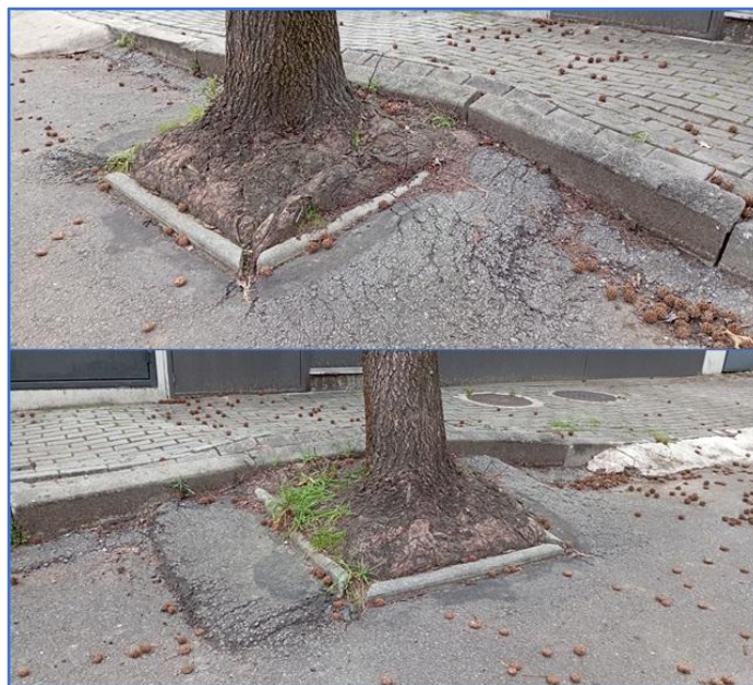
Figura 44 – Imagens de danos provocados junto à caldeira do ID25
