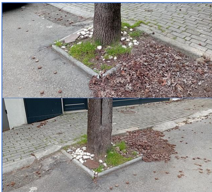
Figura 36 – Imagens de danos provocados junto à caldeira do ID22
