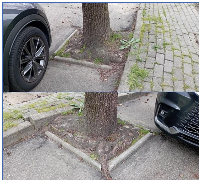
Figura 46 – Imagens de danos provocados junto à caldeira do ID26
