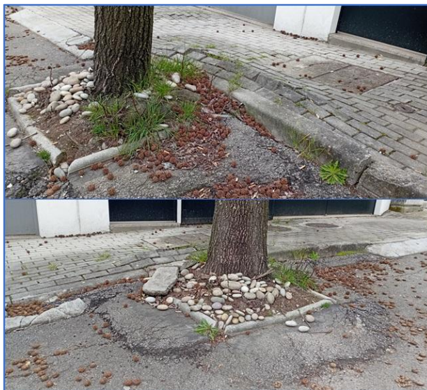
Figura 28 – Imagens de danos provocados junto à caldeira do ID17
