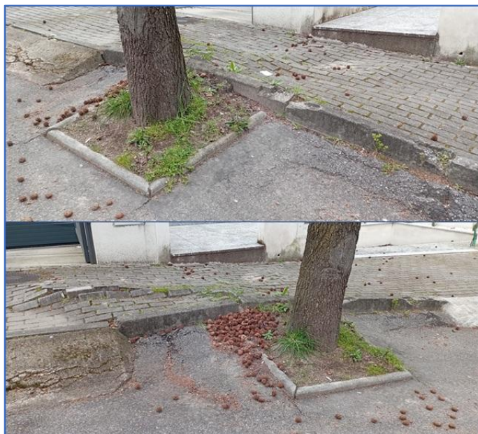
Figura 50 – Imagens de danos provocados junto à caldeira do ID28
