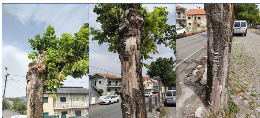
Figura 77 – Estado fitossanitário da árvore
