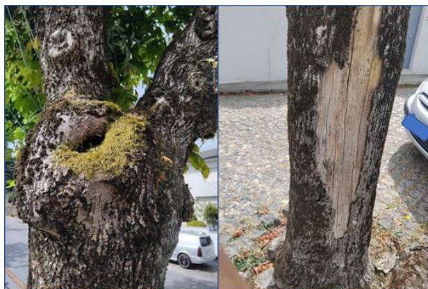
Figura 41 – Estado fitossanitário da árvore
