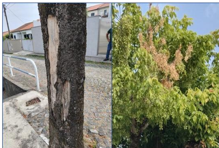
Figura 53 – Estado fitossanitário da árvore
