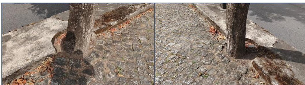
Figura 43 – Aspecto da implantação da árvore
