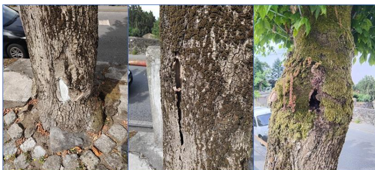
Figura 29 – Estado fitossanitário da árvore
