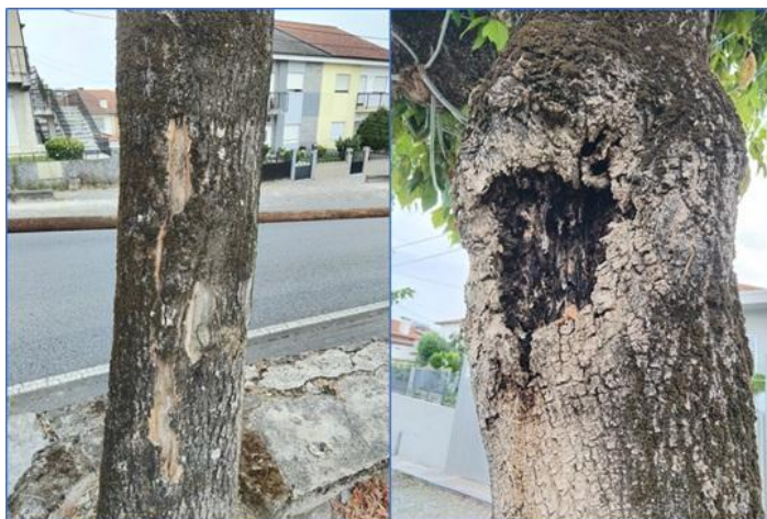
Figura 97 – Estado fitossanitário da árvore
