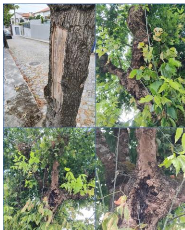
Figura 94 – Estado fitossanitário da árvore
