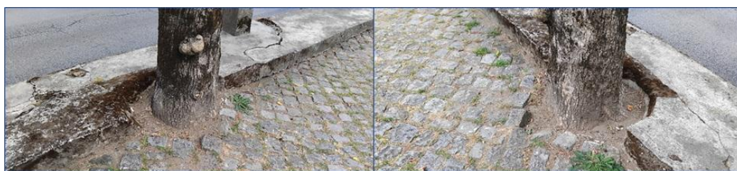
Figura 87 – Aspecto da implantação da árvore
