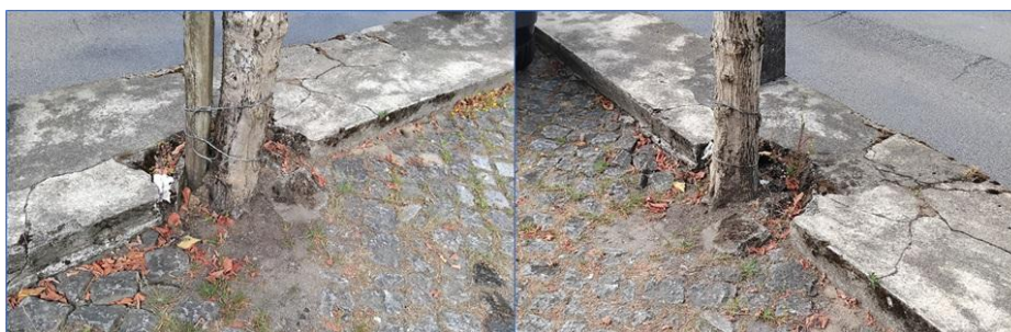
Figura 34 – Aspecto da implantação da árvore
