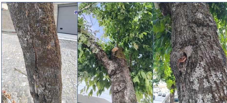
Figura 44 – Estado fitossanitário da árvore
