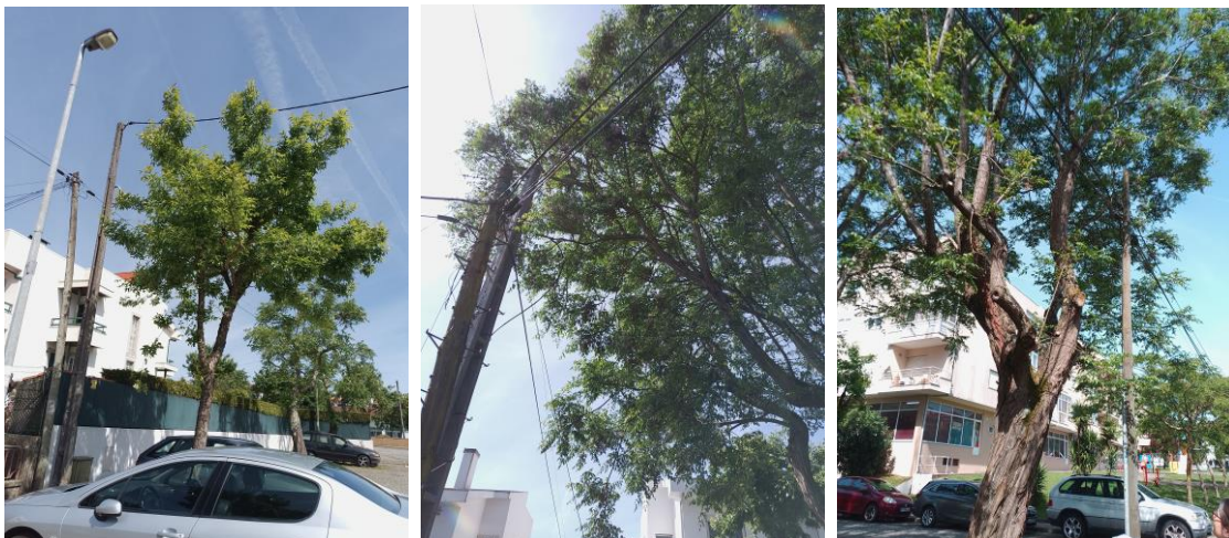
Figura 5 - Fotografias de diferentes árvores em conflito com postes e cabos eletricos e de telecomunicações.
