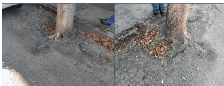
Figura 31 – Aspeto da caldeira
