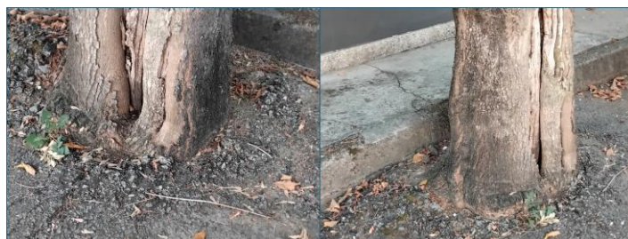
Figura 16 – Aspeto da caldeira
