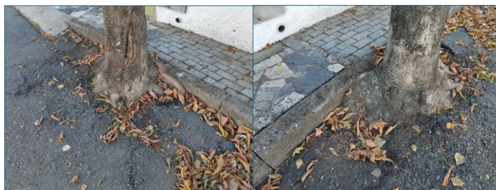
Figura 7 – Aspeto da caldeira
