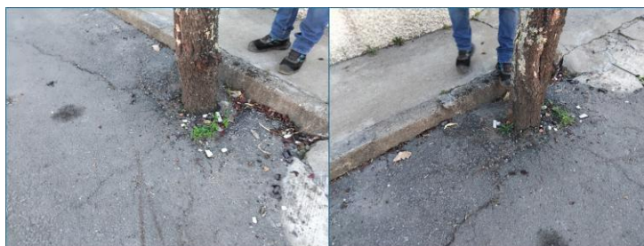
Figura 22 – Aspeto da caldeira
