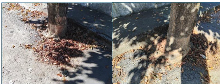
Figura 43 – Aspeto da caldeira
