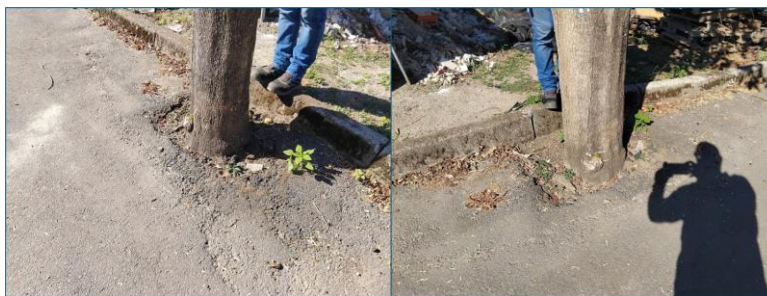
Figura 40 – Aspeto da caldeira
