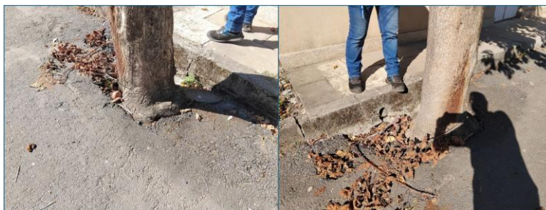
Figura 37 – Aspeto da caldeira
