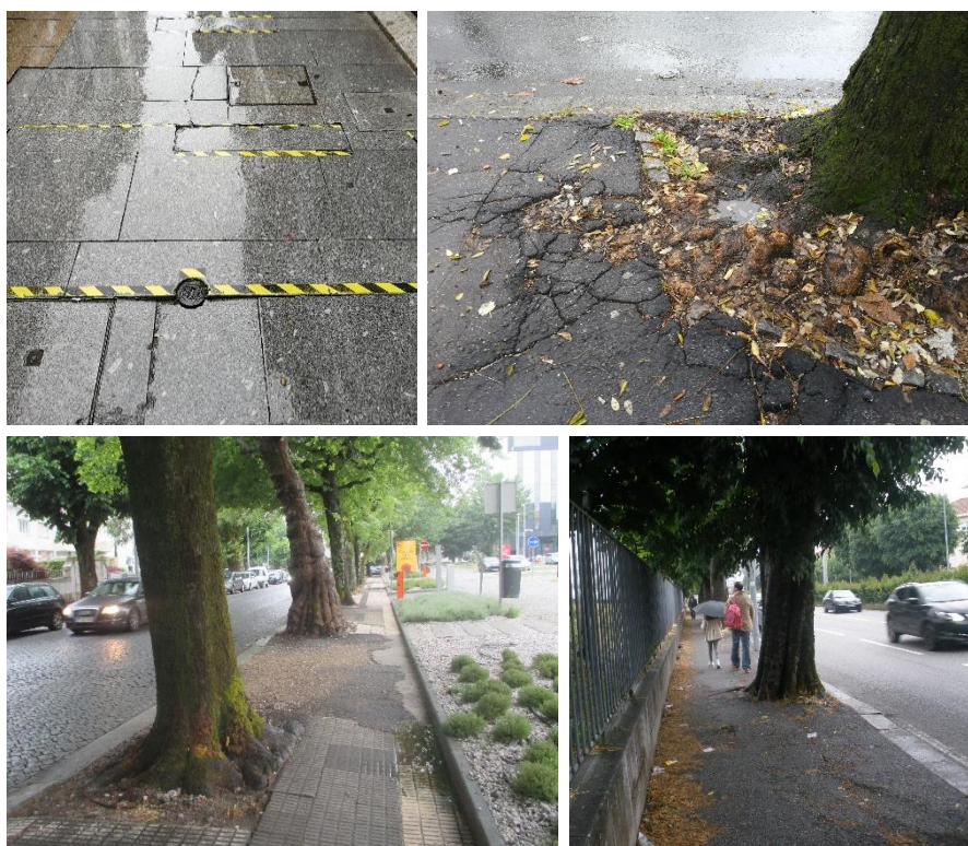
Figura 25. Pavimento degradado e espaços pouco apelativos para a circulação pedonal
