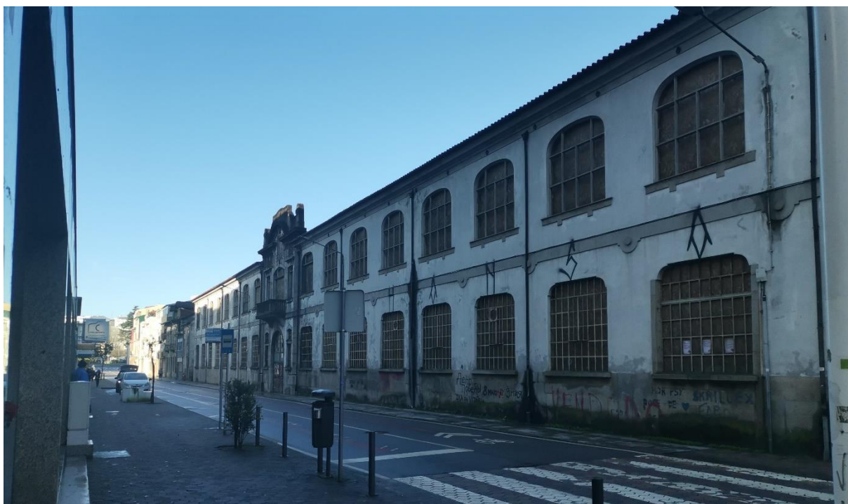
Figura 31: Estado do Exterior do edifício, 2023
