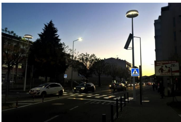
Figura 28 - Iluminação pública com tecnologia LED 33
