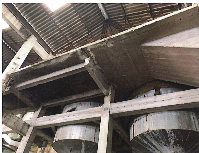
FOTO 48 | Pormenor – Estrutura de suporte de tinas
