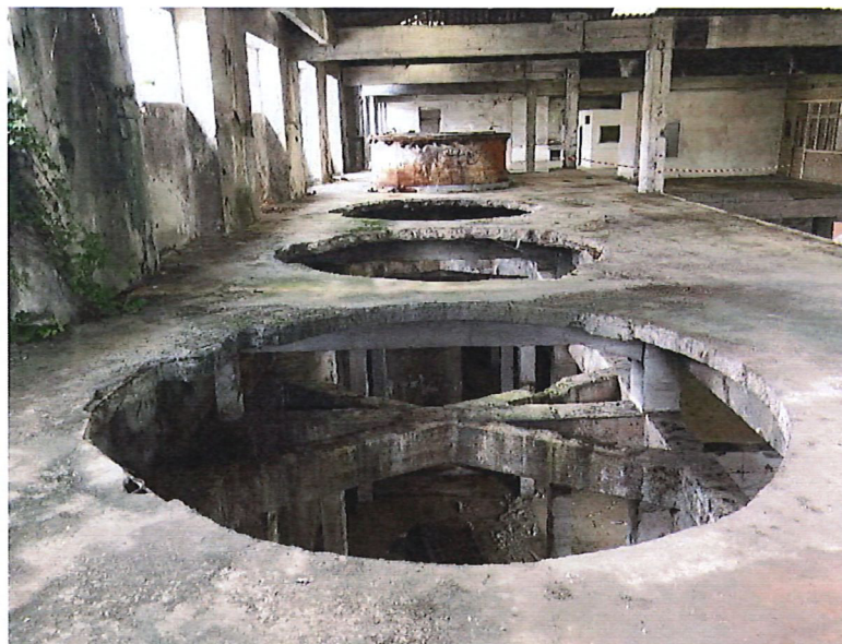
FOTO 47 | Pormenor – Estrutura de suporte de tinas
