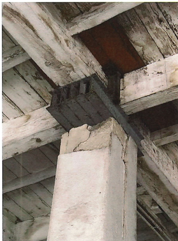
FOTO 32 | Pormenor – Sistema construtivo (Pedra/Ferro/Madeira)
