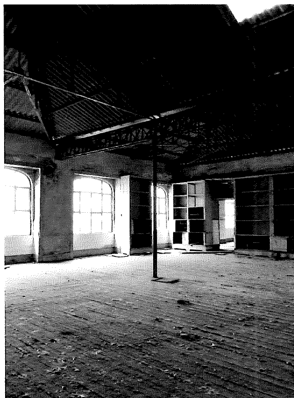
FOTO 38 | Pormenor – Estrutura de ferro cobertura | A Manter / Reforçar
