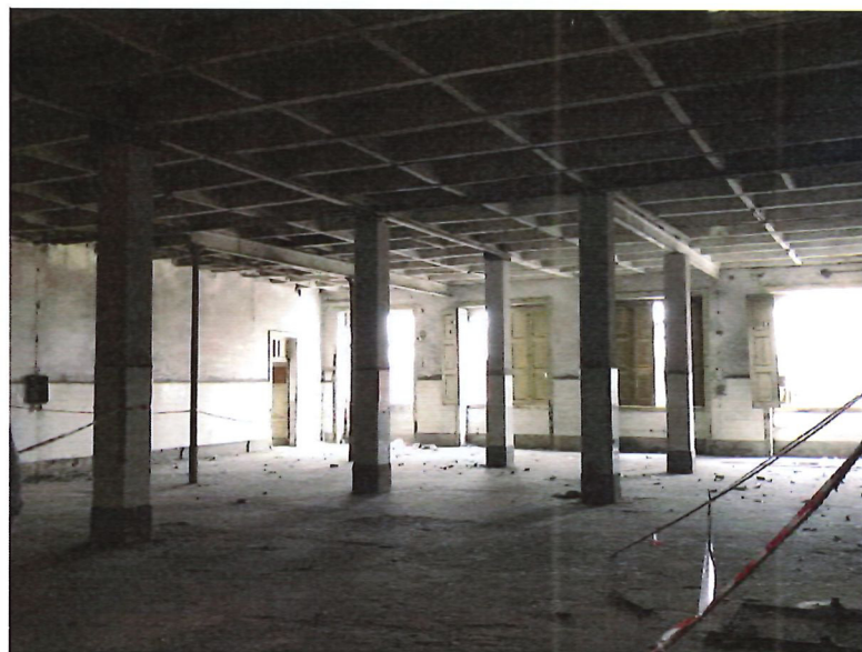
FOTO 30 | Área de pavimento executada em estrutura de madeira | A manter
