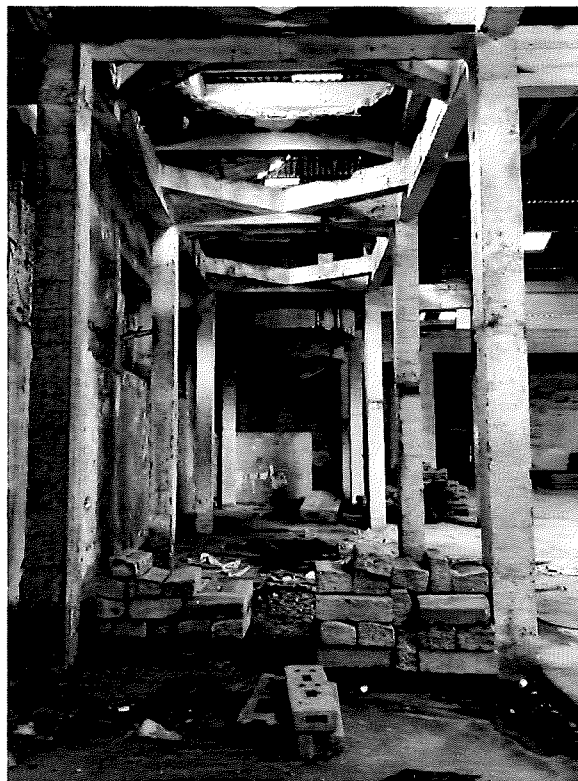
FOTO 21 | Interior – Estrutura de suporte de tinhas
