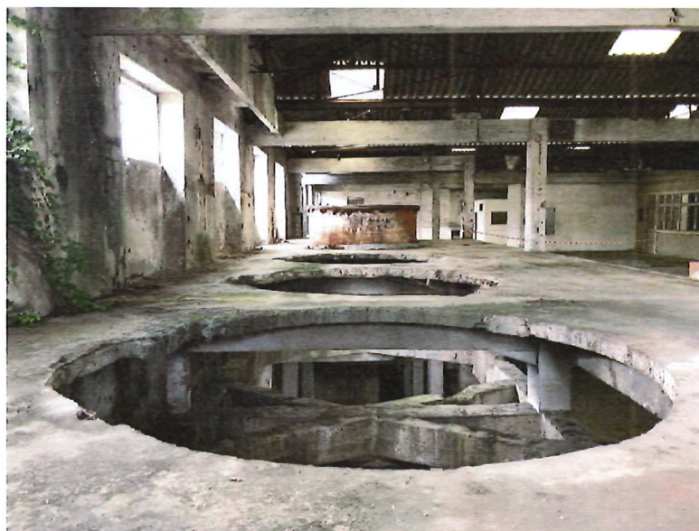
FOTO 45 | Pormenor – Estrutura de suporte de tinas
