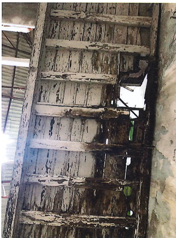
FOTO 24 | Pavimentos de madeira em avançado estado de degradação
