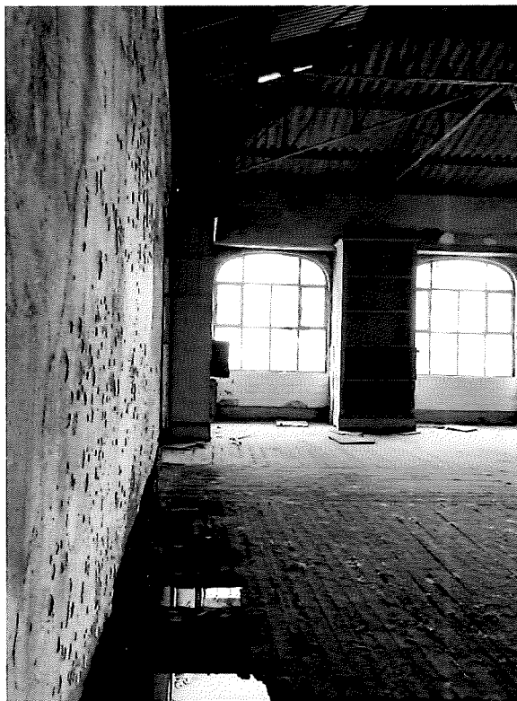
FOTO 37 | Pavimentos de madeira em avançado estado de degradação
