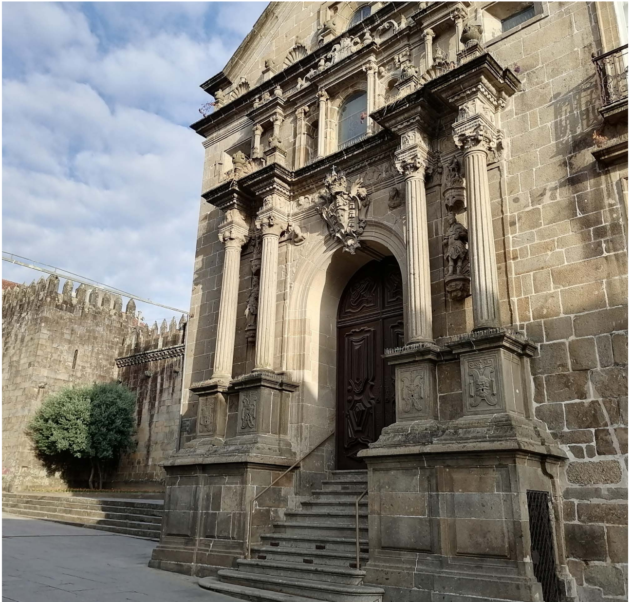
Exterior da Igreja da Misericórdia
