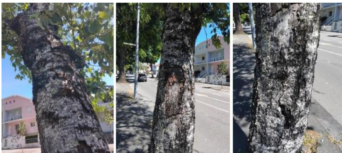
Figura 6 – Fotografias de “defeitos” no tronco do exemplar a avaliar na Av. 31 de Janeiro Nº167, em Braga.
