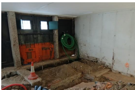
Obra da reabilitação da Casa dos Crivos
